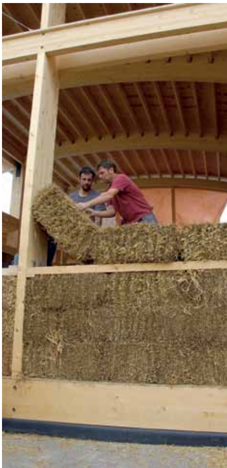
Nosnú konštrukciu stavby tvorí drevený skelet. Slamené balíky majú funkciu výplňového muriva a tepelnej izolácie zároveň. (foto: Ing. arch. B. Hochel)
