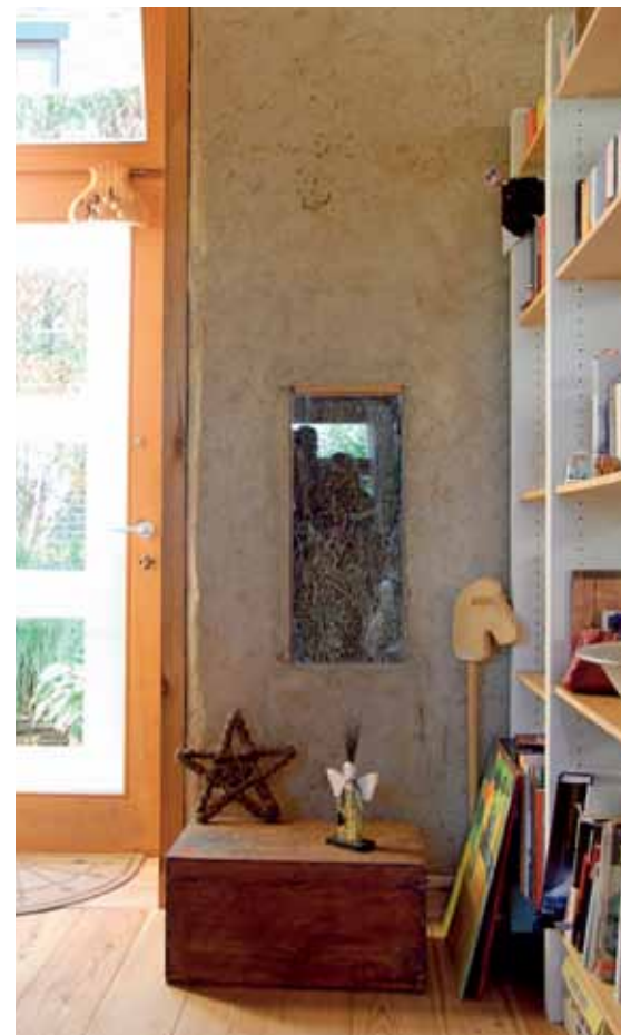
Aby existoval jasný dôkaz, že na stavbu bola naozaj použitá slama, nechali si majitelia časť steny neomietnutú, prekrytú len kusom skla. Len v máloktorom dome je priestor na takýto druh moderného umenia. (foto: Ing. arch. Z. Kierulfová)
